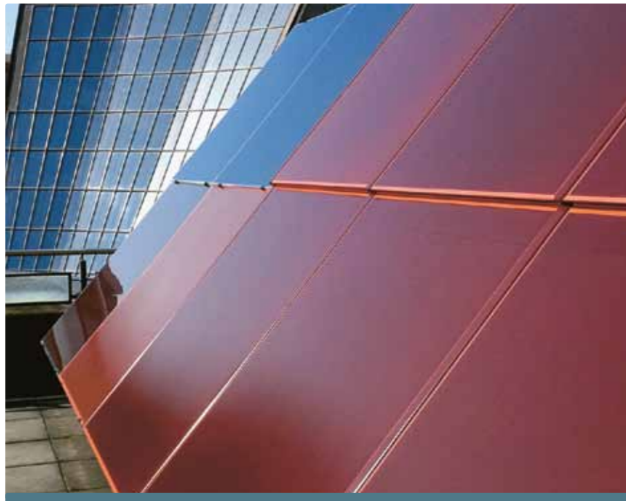
Photovoltaik-Panels in ziegelroter Farbe – das Projekt Archinsolar mit dem PV-Lab der EPFL in Neuchâtel. Das CSEM hat bereits eine erste Serie von 150 Modulen realisiert. Foto: © CSEM 2014
