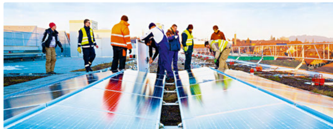
Abb. 2: Teil-Autarkie von Gebäuden, Quartieren und Regionen durch die richtige Speicherung und Steuerung als Ziel
